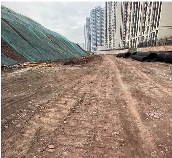
照片 3 项目现状
