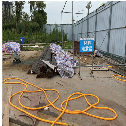
照片 4 项目现状
