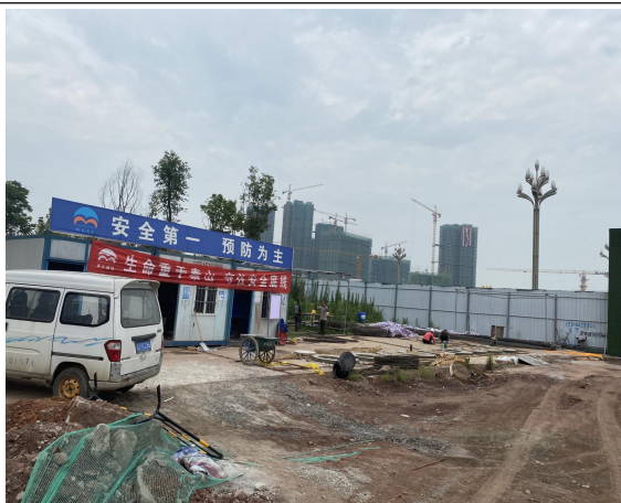
照片 5 项目现状
