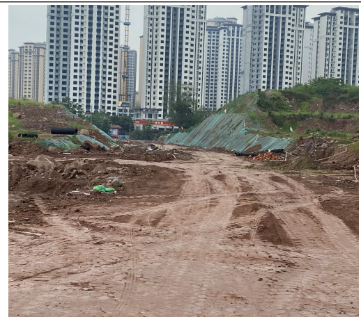
照片 6 项目终点
